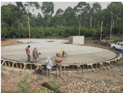
LOSA DEPÓSITOS DE AGUA POTABLE
