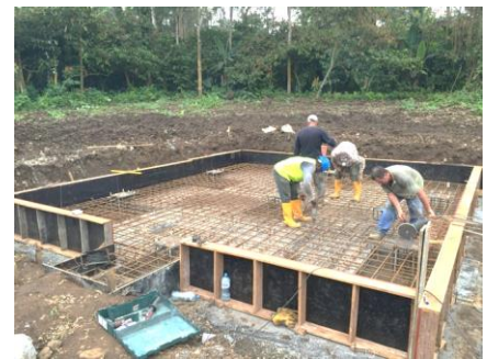
ENCOFRADO Y MALLAZO DEPÓSITO ELEVADO
