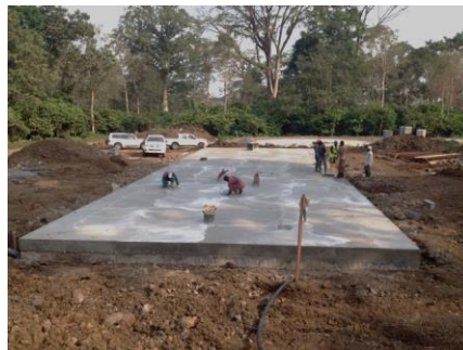
LOSA PLANTA POTABILIZADORA
