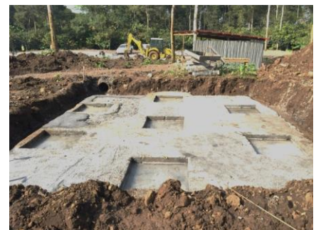
LOSA DEPÓSITO ELEVADO
