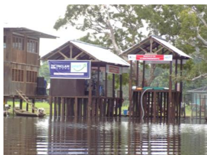
INAUGURACIÓN PLANTA POTABILIZADORA
